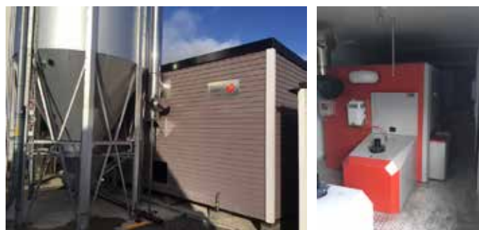
Fristående panncentral med silo och pelletspanna på plats efter ca 4 h.
