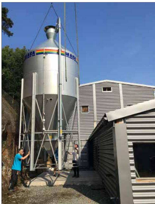
Grimmereds Verkstad AB, konverterar från olja till biobränsle. Den fristående panncentralen är på plats och snart också silon.
