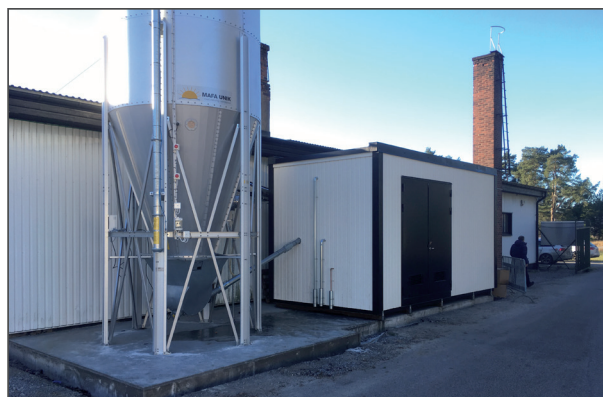
Fristående panncentral och silo.
